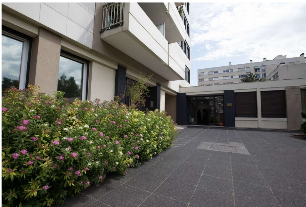
Accueil bâtiment annexe – Salles de formation – lieu de vie stagiaires & plateau technique 102/110 avenue Marceau – fond de cour intérieure – 440 m 2
